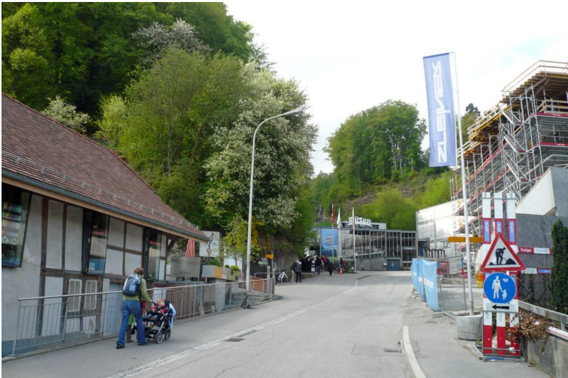
Abbildung 2: Foto vom 05.05.2013 bestehende Situation
