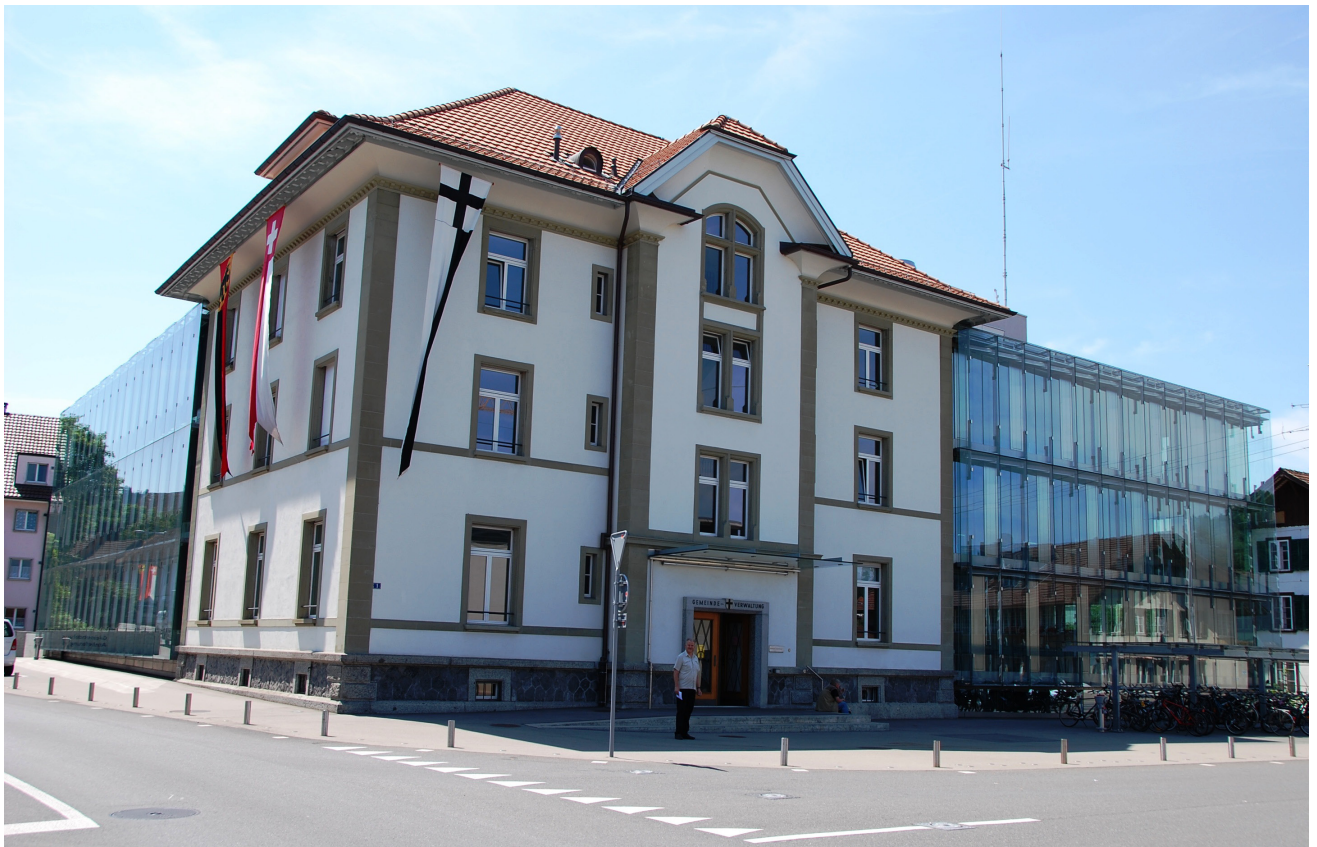
Gemeindehaus Köniz: Das 2004 bezogene Gebäude zeichnet sich durch den MINERGIE-Standard aus.
