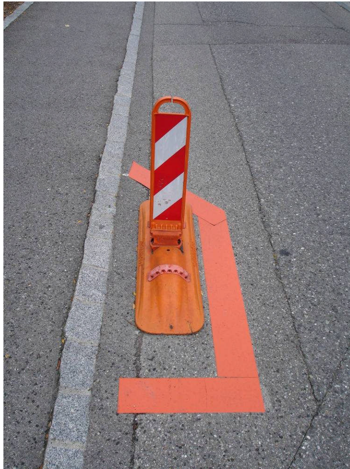
Abb.: Provisorischer Poller auf inhomogener Belagsfläche
