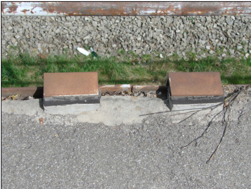
Foto-Nr. 16: Verstärkungsmassnahme. Die Auflagerwinkel haben sich auch hier verschoben.
