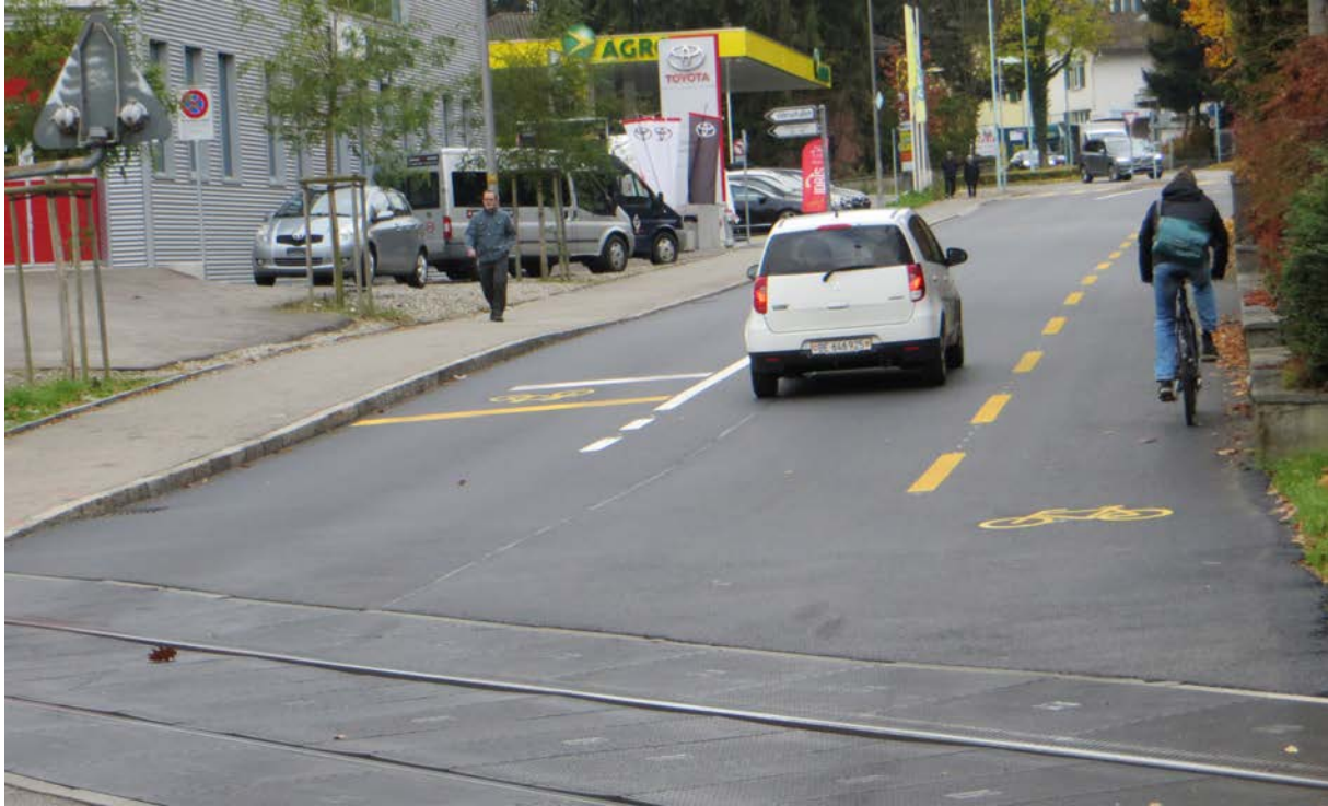
Abb. 18: Verbesserte Situation für den Veloverkehr auf der Könizstrasse: vorgezogener Haltebalken Richtung Bern, breiterer Velostreifen Richtung Köniz. Foto: Rolf Albisser
