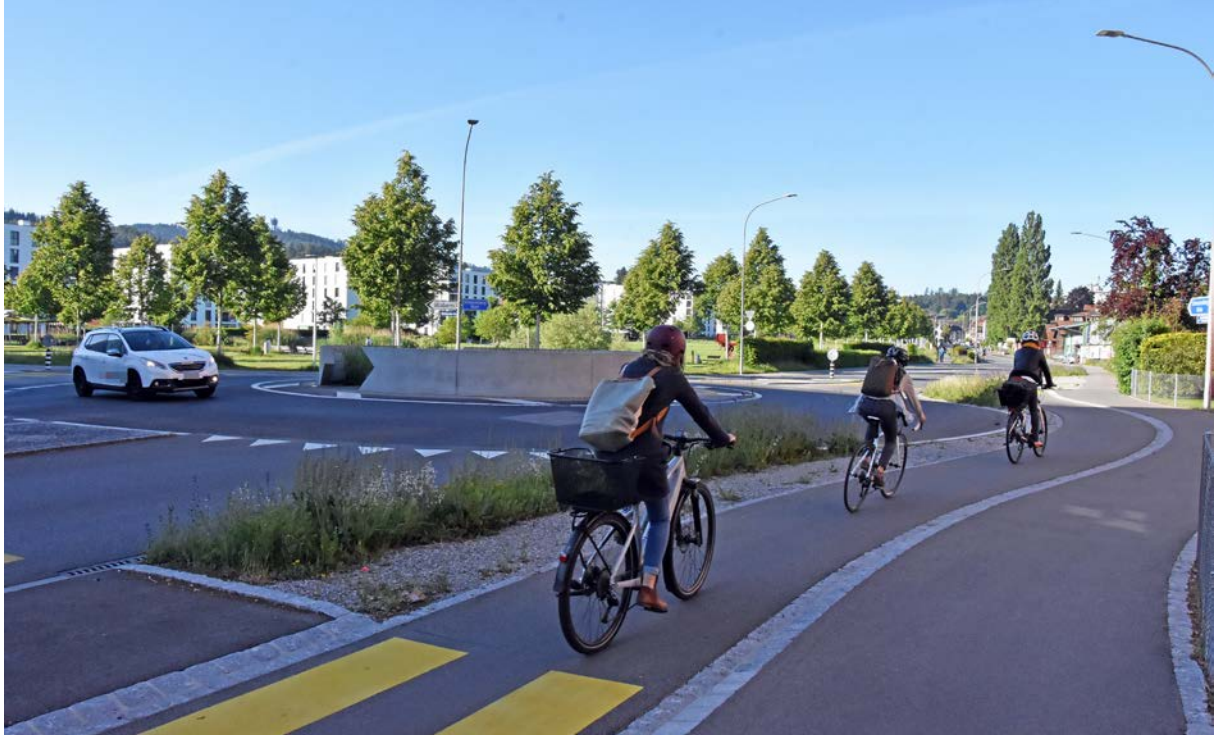
Abb. 14: Sämtliche Massnahmen von Fuss Velo Koeniz sind auf fussvelokoeniz.ch einsehbar und beschrieben. So auch der Velo-Bypass beim Kreisel Schwarzenburg-/Bündenackerstrasse. Foto: Daniel Bill
