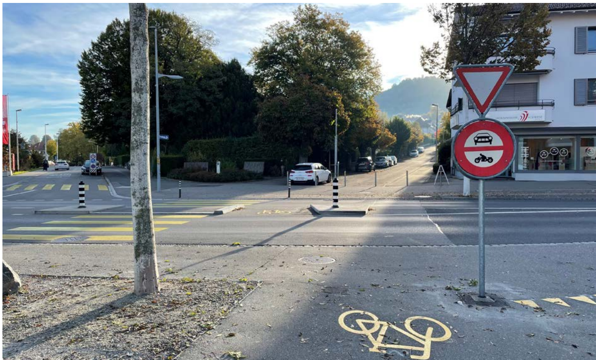
Abb. 11: Nachher: Die Ausfahrt wurde für den Autoverkehr gesperrt und damit die Sicherheit für den Fuss-/Veloverkehr erhöht. Velofahrende dürfen neu links abbiegen oder geradeaus fahren. Zudem wurden bei der Baumgruppe die Betonplatten entfernt und damit Stolperfallen eliminiert. Foto: Tanja Hug
