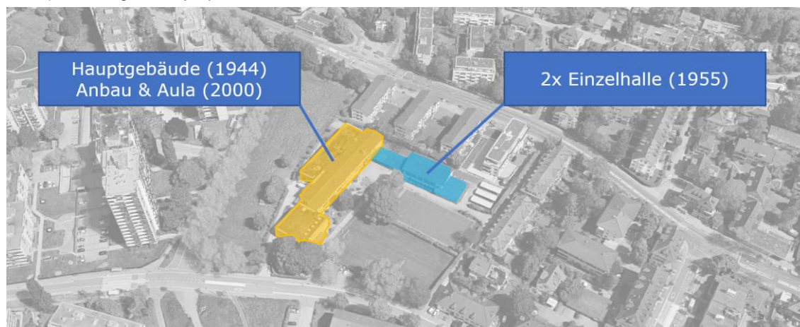
Abb. 2): Luftaufnahme Schulareal Wabern Morillon, inkl. Gebäudeinfos
