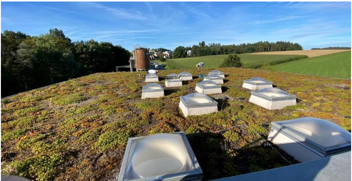
Die Gemeinde geht mit gutem Beispiel voran, beispielsweise mit dem begrüntem Hausdach des Werkhofs an der Muhlernstrasse 101. Auch private Flächen bergen ein grosses Potenzial für die Förderung der Biodiversität. (Bild 8)
