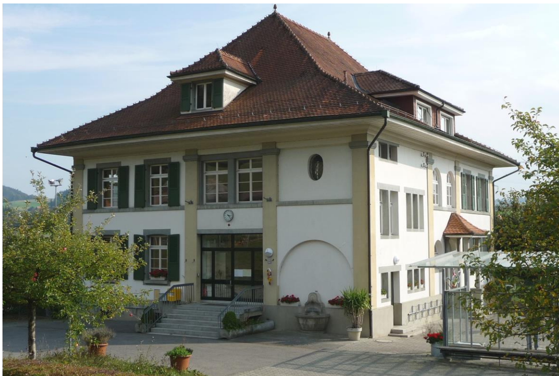
Bild: Denkmalpflege des Kantons Bern
