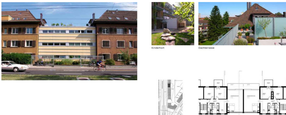
Abbildung 26: Beispiel Winterthurerstrasse 111-117, Zürich; Ergänzen einer bestehenden Reihenbebauung, Lärmschutz, marktgerechte Wohnungen, attraktive Freiräume zu Wohnungen und Siedlung in einem. Quelle: http://www.bgoberstrass.ch
