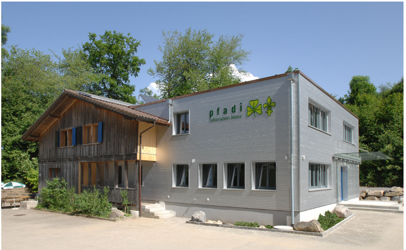
Das Büschiheim ist das erste MINERGIE-Pfadiheim der Schweiz. Die Photovoltaikanlage auf dem Dach haben die PfadfinderInnen selber installiert.
