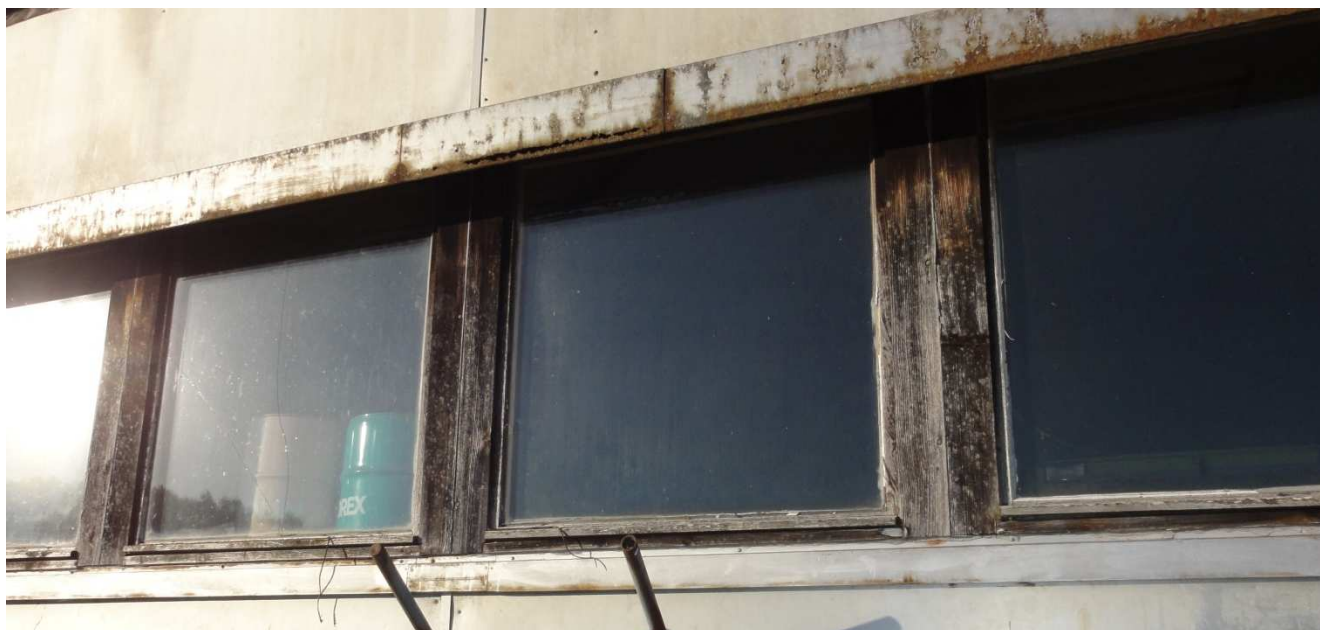
Fensterband aktueller Zustand
