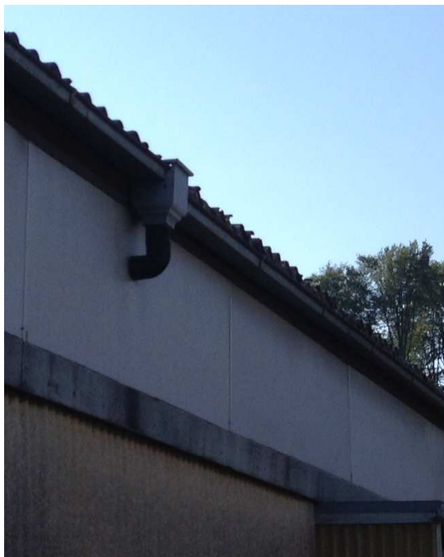
Dachrand mit Rinne und Ablauf
