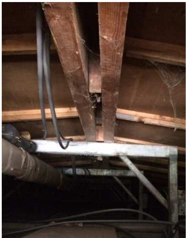
Dachkonstruktion mit Metalljoch
